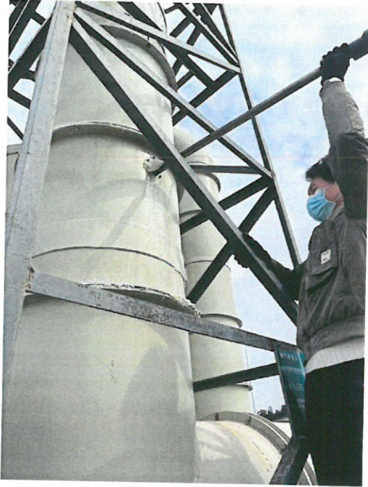
污水处理站废气排放口 (FQ-21283) G1
