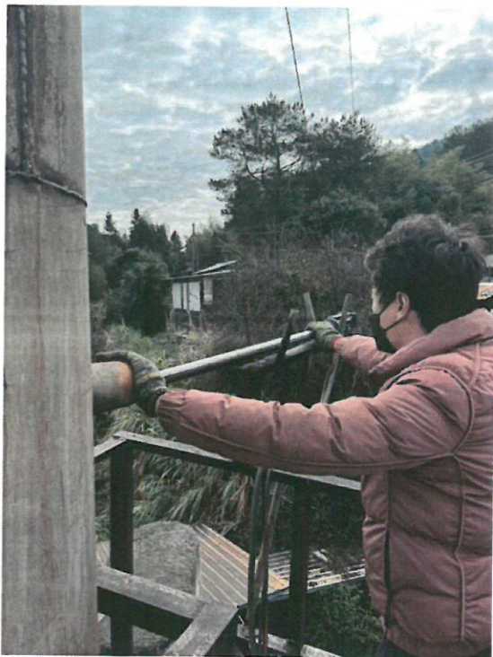
锅炉废气排气筒出口(FQPK-0001)G1
