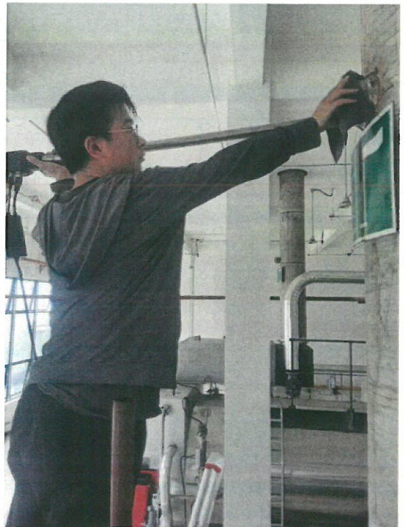
锅炉废气排放口 1# (FQ-21281) G2
